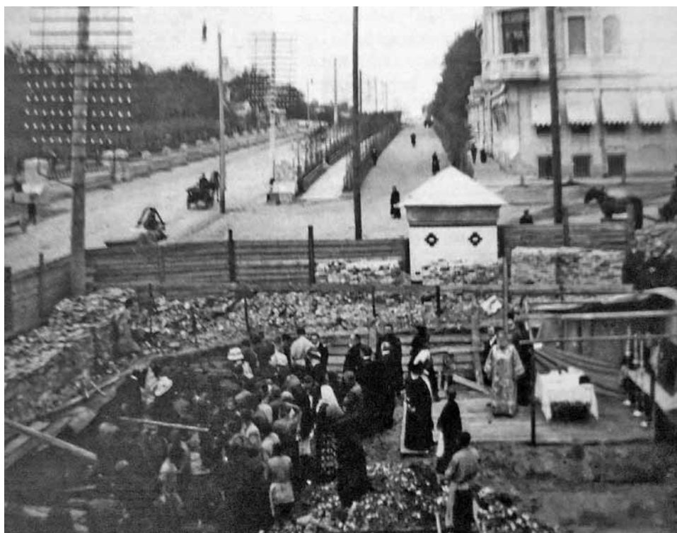
Ил. 5. Музей промышленности и искусства Д. Г. Бурлыгина. 1912-1915 гг. Архитектор П. А. Трубников. Закладка здания. Фото 1912 г.
