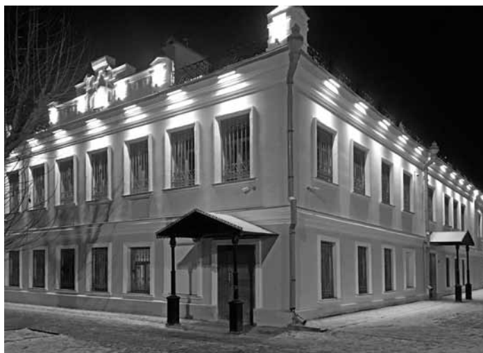
Ил. 23. Фондохранилище музея. Передано МИХМ в 2014 г. С 2019 г. — фондохранилище музея. Фото 2019 г. МИХМ. Цифровой архив
