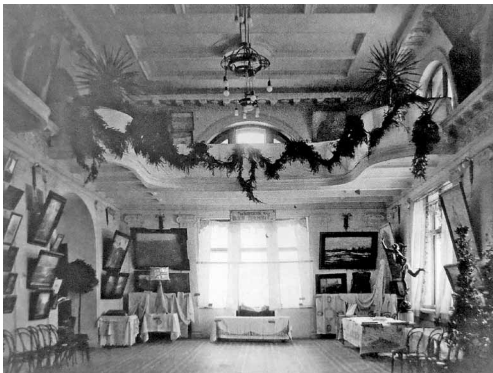
Ил. 6. Музей промышленности и искусства Д. Г. Бурылина. 1912-1915 гг. Архитектор П. А. Трубников. Картинная галерея. Фото 1915 г.
