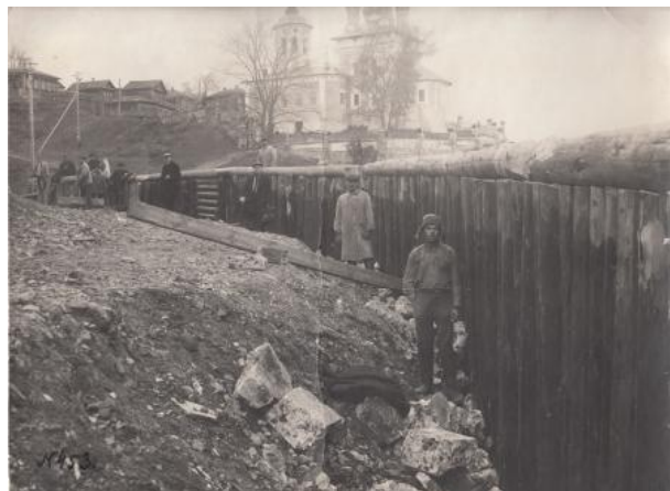
Ил. 22. Укрепление набережной в районе Окского сада. Фото. 1920-е. Муромский музей. М-12179
