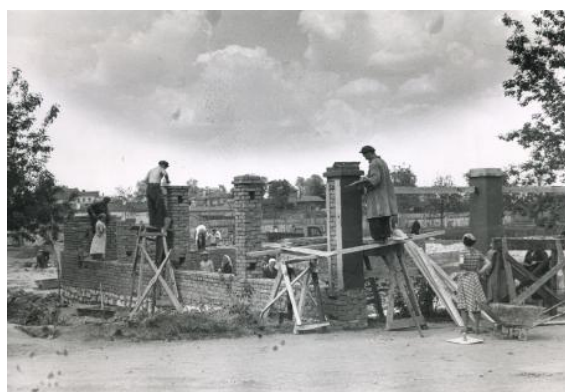
Ил. 25. Строительство центрального входа в Окский парк. 1965-67. Фото. Муромский музей. НВ-3122
