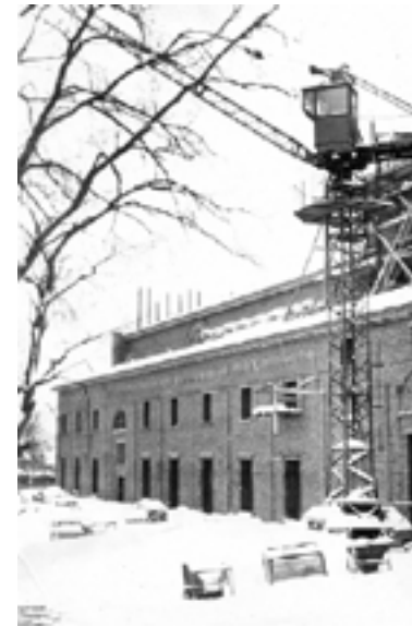
Рис. 2. Кран на строительстве дворца культуры
