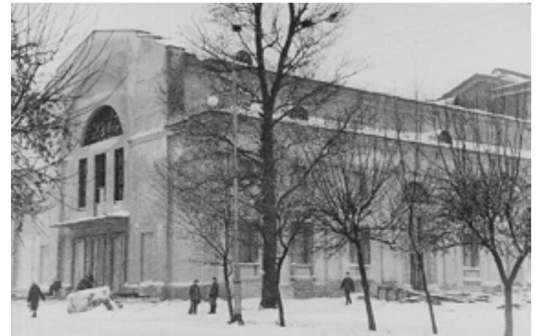
Рис. 3. Строительство дворца культуры, здание без отделки
